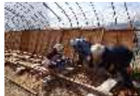
二本の角材の上に板を乗せ水平器を置いて計ります。右端 米山。
